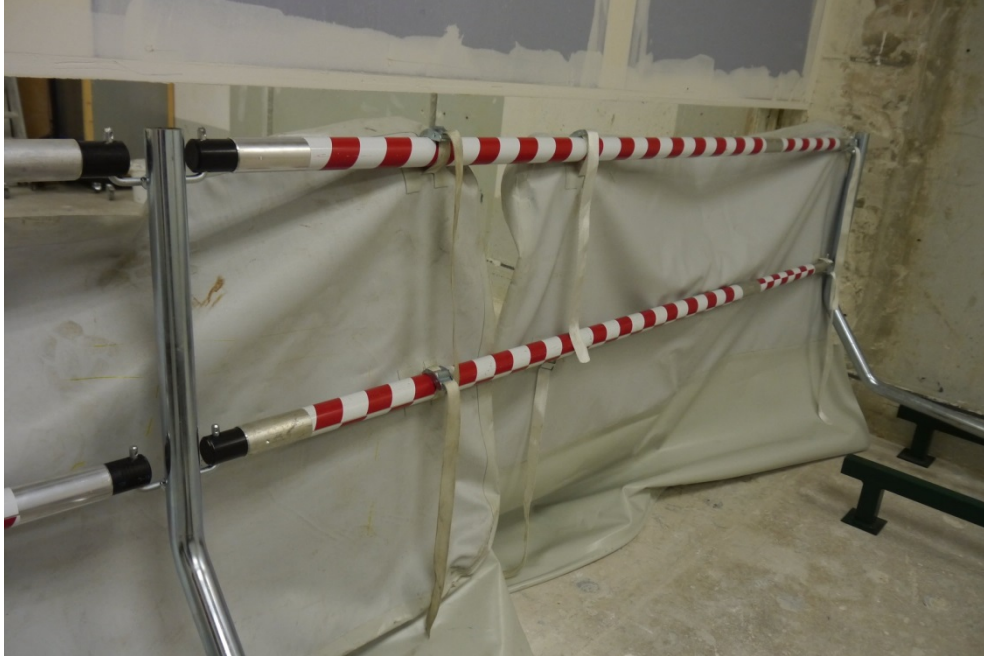
Abbildung B.3. Lärmschutzmattensystem während der Montage: Stahlrohrgestänge mit noch nicht aufgeblasenen Matten vor der Prüfföffnung.
