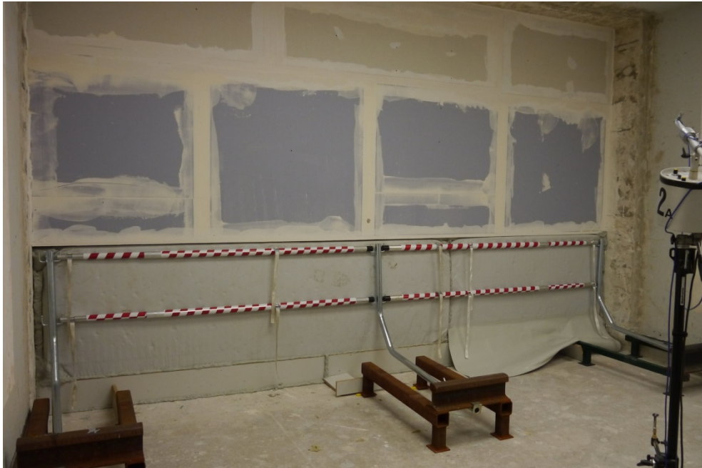
Abbildung B.9. Prüfaufbau 2 im Wandprüfstand: Ansicht vom Senderraum aus.
