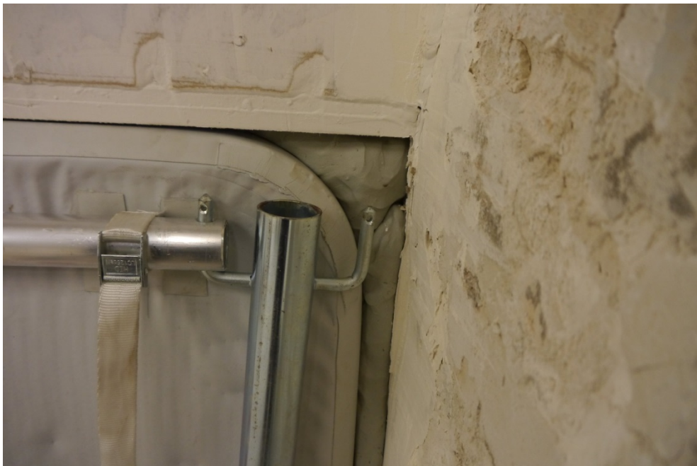
Abbildung B.6. Prüfaufbau im Wandprüfstand: Detail Abdichtung zum Prüfstand mit dauerplastischem Dichtstoff (senderaumseitig).
